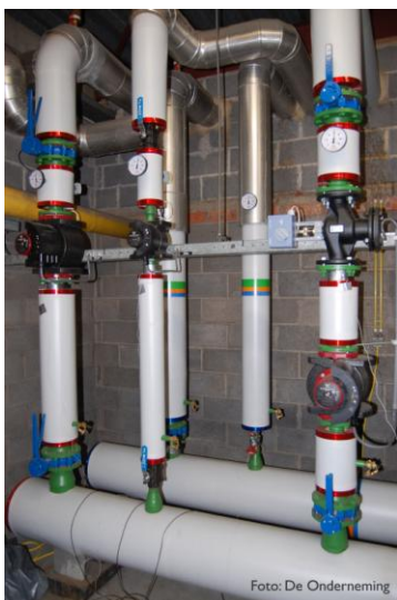
De hydraulische aansluiting werd omgebouwd om op variabel debiet te kunnen werken.
